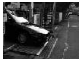
ゆとろぎ立体駐車場1階(上)2階(下)出入口
