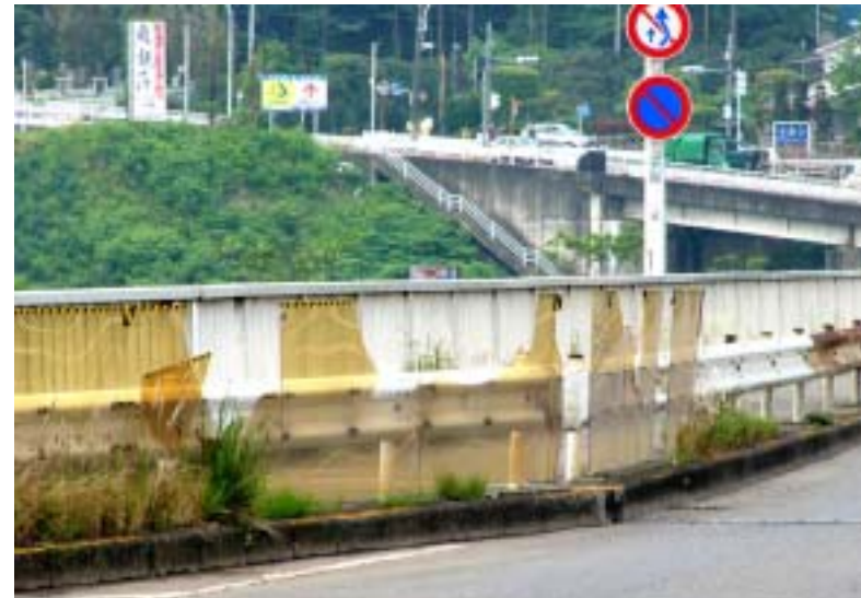
破損が目立つ「羽村大橋」の水はね防止柵
