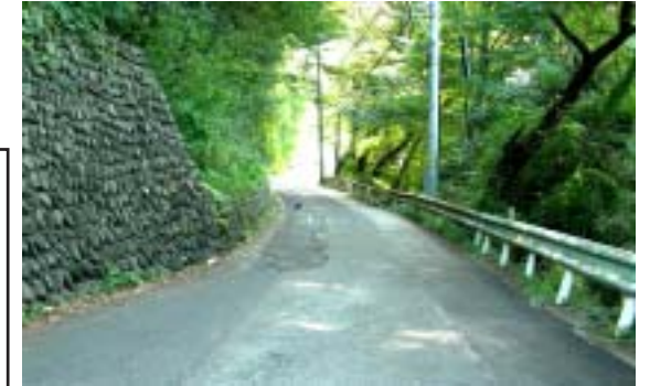
これから工事予定の道路
