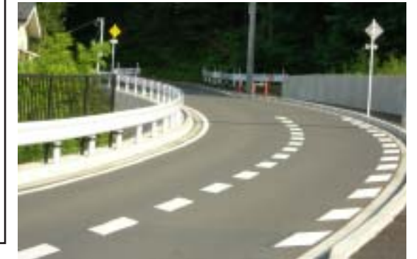
工事が完了した道路
