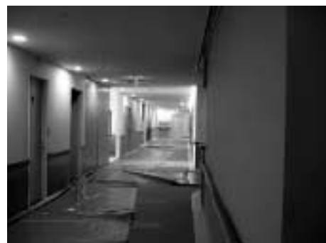
建設中の入院病棟。明るく開放的な間取りになっています。
