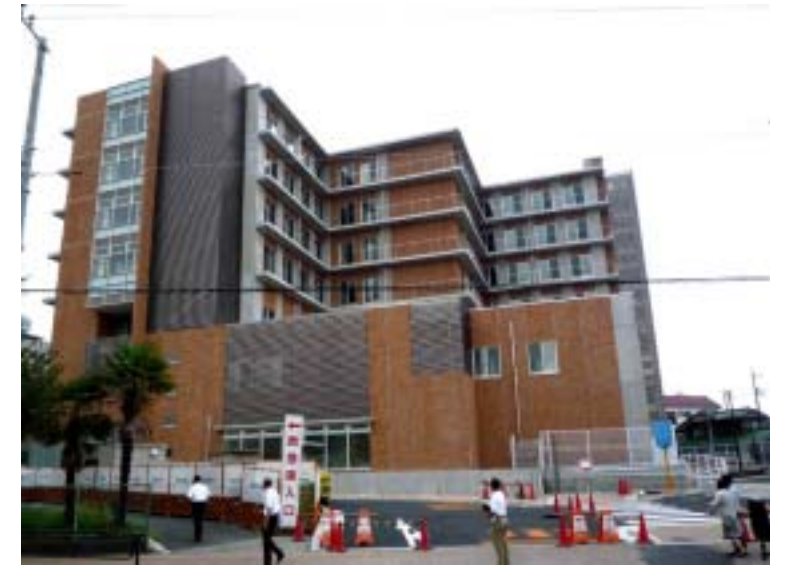
第1期工事が完了した新福生病院
