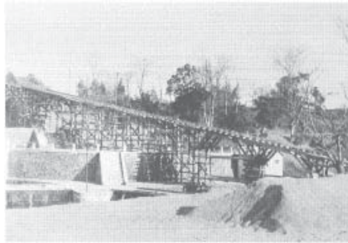
武蔵村山市教育委員会発行「村山・山口貯水池建設工事写真集」より
