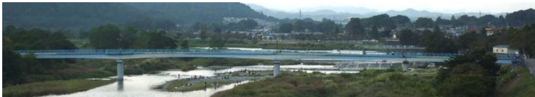
堰下橋の全体
