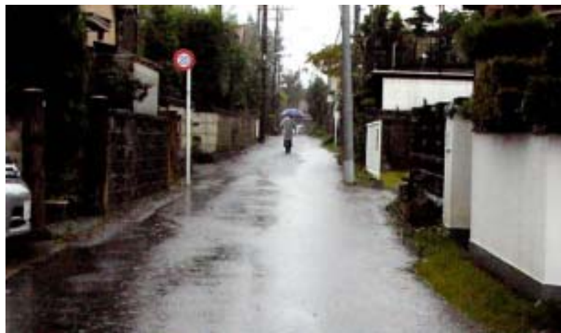
生活道路の半分が雨水に浸かっている。(玉川町)
