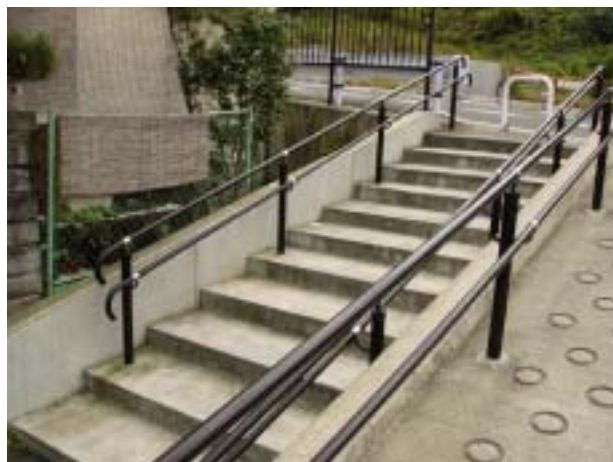
清流町に最近設置された階段と手すり
