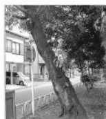
根元が腐り、危険な樹木
